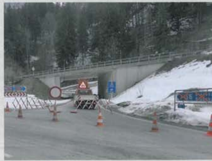
Bild 5: Provisorische Sperre der Einfahrtsrampe Anschlussstelle Dalaas
